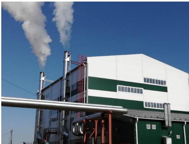
(製造工場外観)
