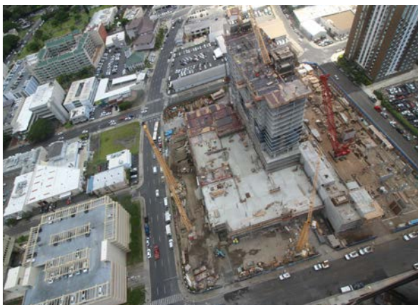
※現地写真 (平成 28 年 9 月 27 日)
