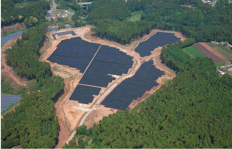
※山武市椎崎太陽光発電所
